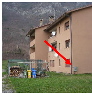
2) TUBO GAS METANO E CASSETTA NEL FABBRICATO 5C ( A QUESTA SARA' AFFIANCATO L' ALTRO CONTATORE PER L' ALLACCIO IN C.T)
