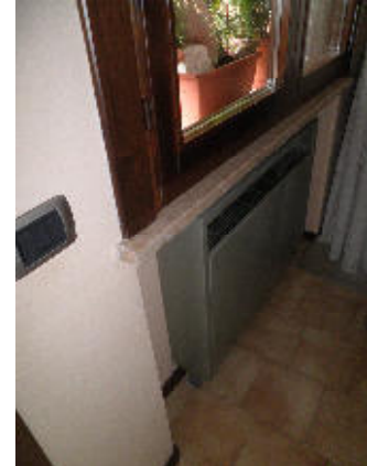
6) VETTELCONVETTORE ALL' INTERNO DI UN ALLOGGIO
