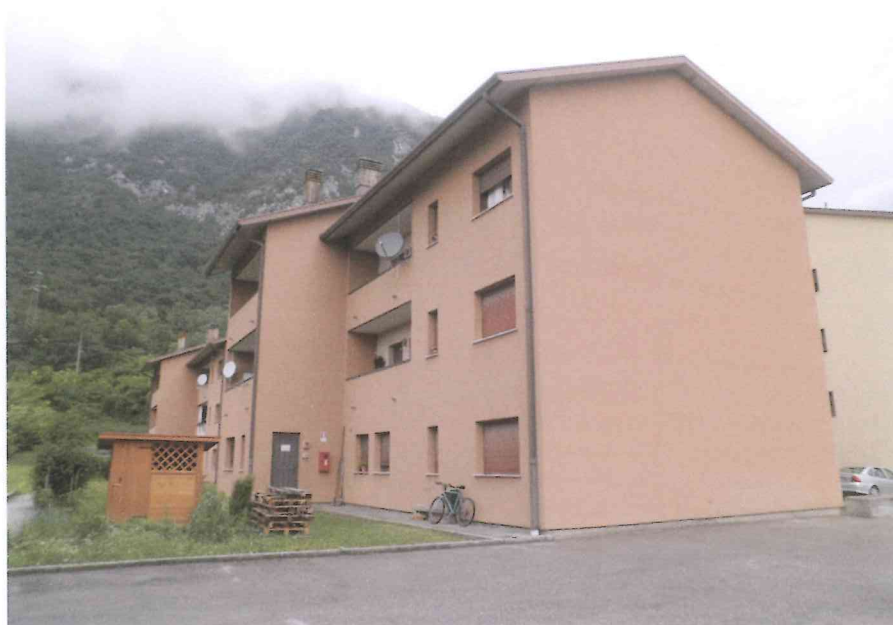
FOTO 1_Vista dei prospetti sud-est ( EDIFICIO 5D)
