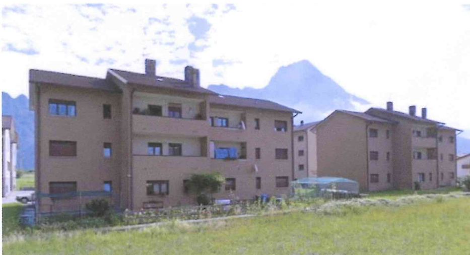
FOTO3_Vista dei prospetti sud dei due fabbricati
