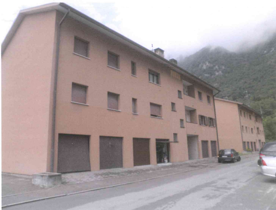
FOTO 2_Vista dei prospetti nord dei due fabbricati
