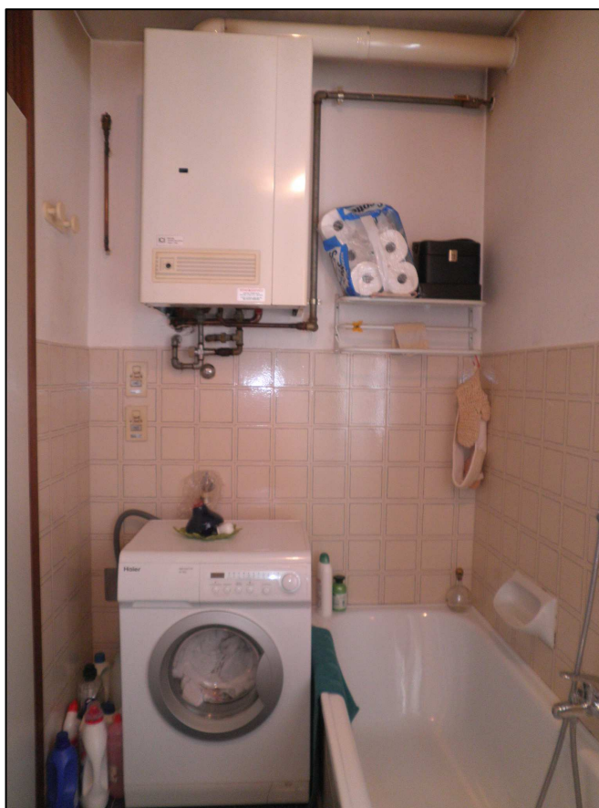
civ. 39 - particolare caldaia in sostituzione
