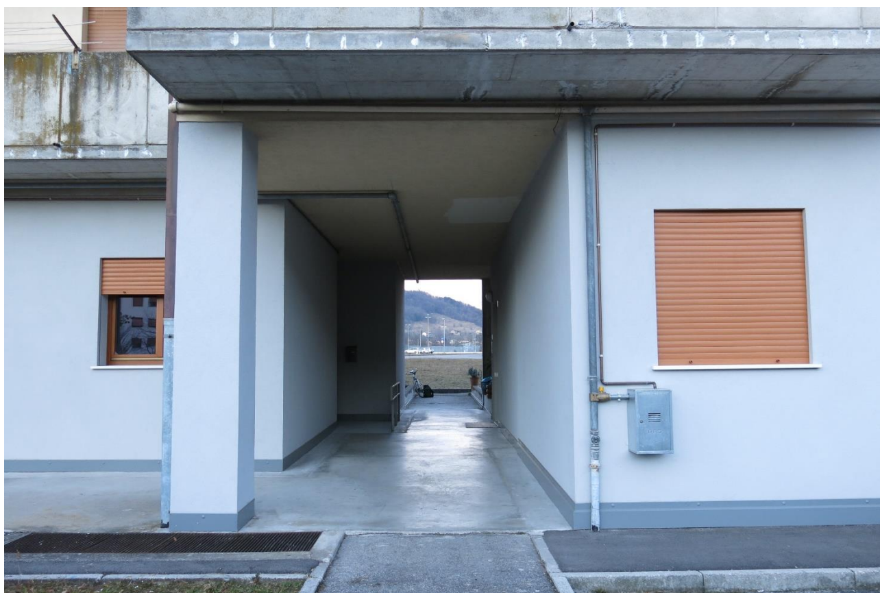
Figura 10 I portici passanti (previsto isolamento all'intradosso del solaio)
